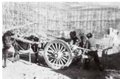
建设初期的永登水泥厂
